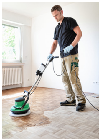
Práce s 2K olej na dřevo a FloorXcenter
